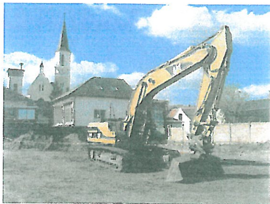
Abbildung 1: Beginn der Erdarbeiten – Aushub
